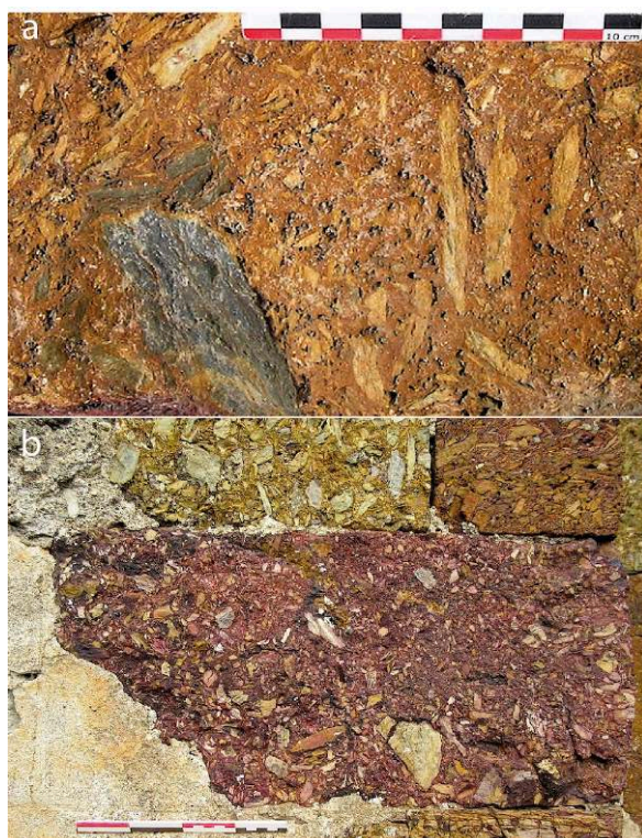
a : Baillaury. Distribution quelconque des clastes schisteux beige ocre (altérés) et gris foncé dans du ciment ferro-siliceux, nombreuses cavités ; b : Castelnou, église de Sainte-Marie du Mercadal (xii e siècle), le hasard de l'architecture superpose des pierres avec des ciments ferro-siliceux plus ou moins hydratés allant du rouge sanguin à l'ocre jaune.
