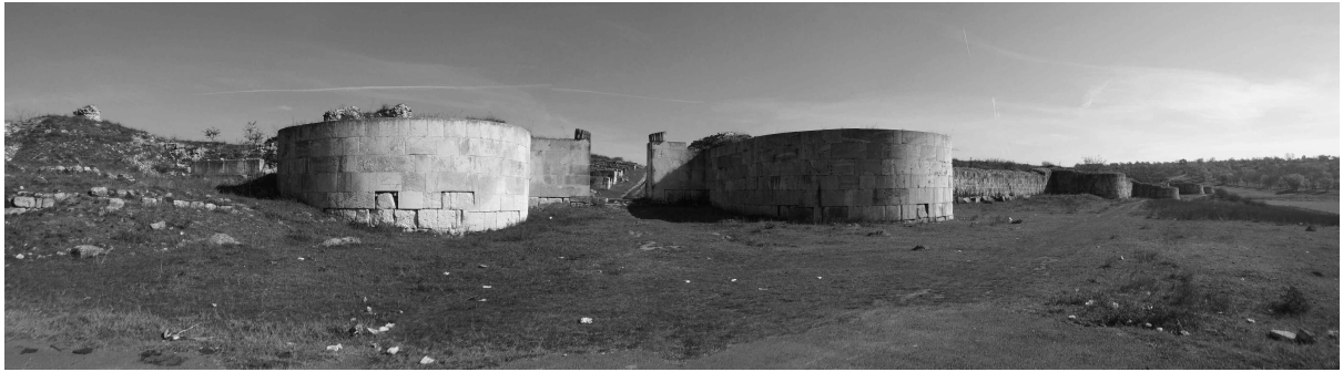
Figure 4 : La cité de Tropaeum Traiani, fondée par Trajan et restructurée sous Constantin. Porte Ouest. Cl. G. Castellvi. DAO panoramique Gu. Castellvi.
