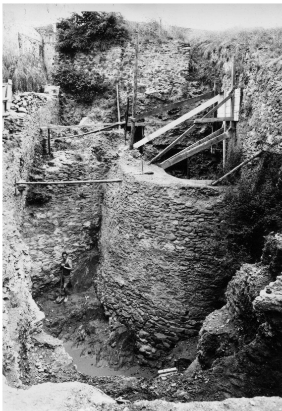
Figure 6 : vue générale de la tour fouillée en 1963-1964 (archives J. Llado).
