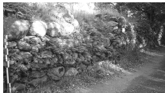
Figure 2 : Mur de terrasse de l'ancien chemin de Maureillas, bâti avec de gros galets issus de l'ancien bourrelet alluvial. Cliché J. Kotarba.
