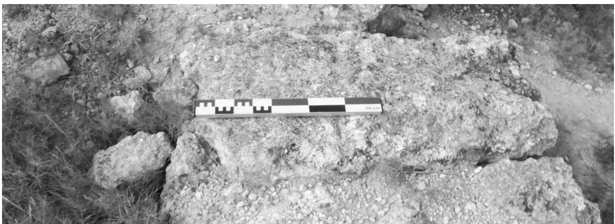
Figure 4 : mur est (cliché : G. Eppe, juin 2013)
