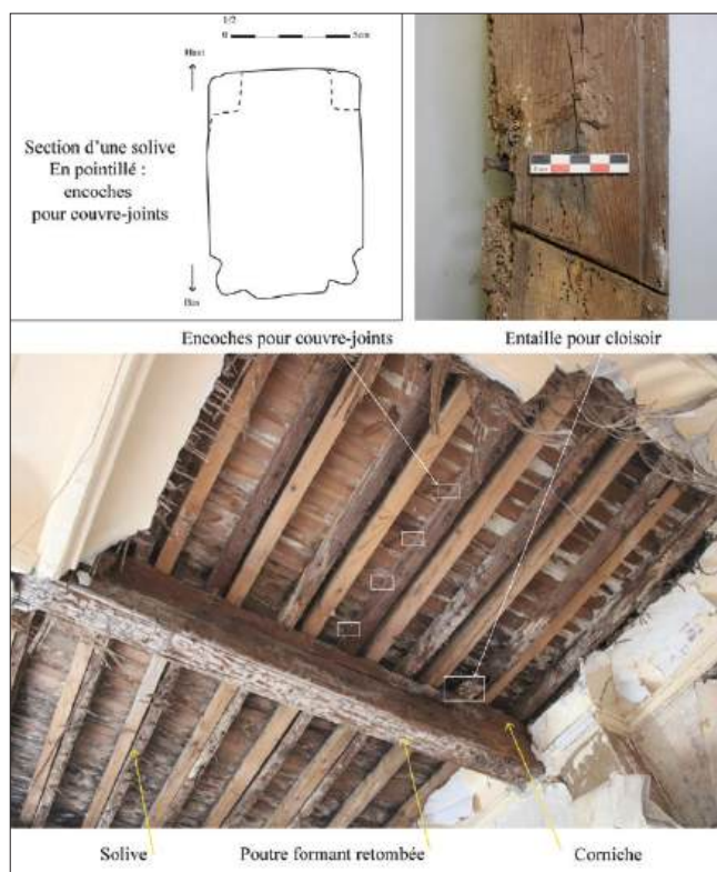
Figure 6 : Plafond à la française du n°36 rue de la Lanterne avec détail des parties sculptées, et relevé de la section d'une solive (clichés et DAO : SAD66).
