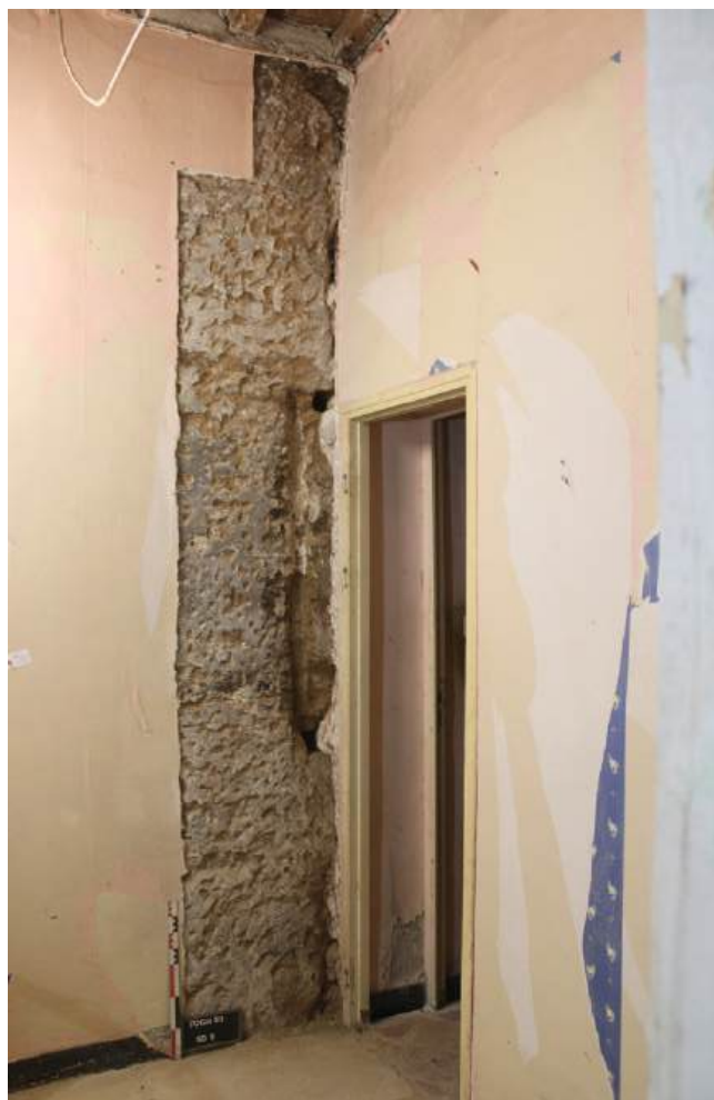
Figure 4 : Vue générale du sondage 9, montrant la présence de pisé jusqu'au plafond du R+1, ainsi que l'empreinte d'une potentielle baie (tasseau vertical et trous de tasseaux horizontaux) (cliché : SAD66).
