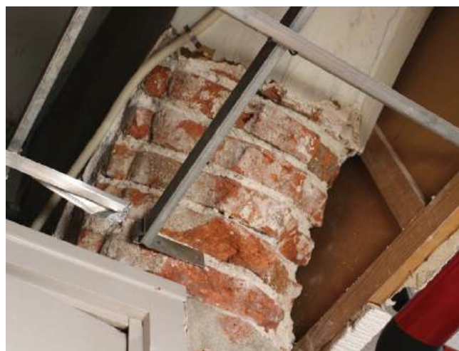
Figure 7 : Détail d'un sondage dans l'un des arcs en brique moulurée du n°37 rue Maréchal Foch (cliché : SAD66).
