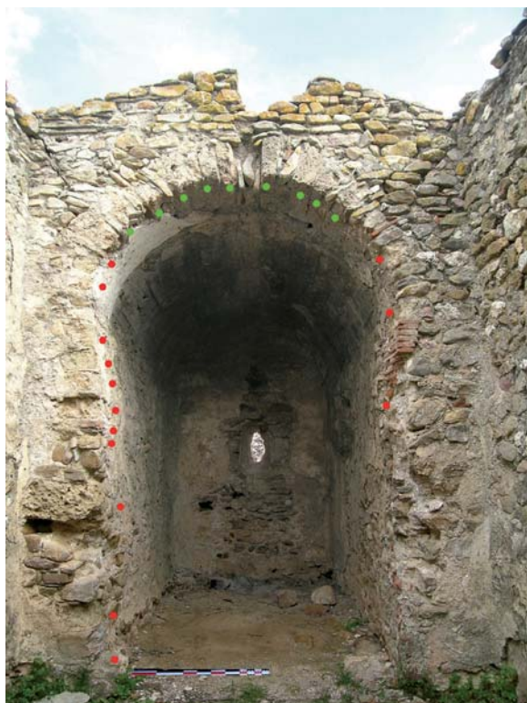
Figure 14 – Église Sant-Vicenç de Tàpies (Fourques). Vue intérieure de la petite église préromane du Xe siècle et de son chevet plat (mire : 1 m). L'arc du chevet trapézoïdal est armé sur les montants par des blocs parementés en tuïre (points rouges), certains ayant disparu sur le montant de droite qui est sommairement réparé avec des briques. Par contre, les parements sommitaux de l'arc outrepassé sont réalisés en travertin, roche également résistante à la compression, mais bien plus légère (points verts). La voûte porte des traces de planches du coffrage dans le mortier (D.A.O., M. Martzluff).
