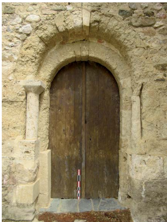
Figure 9 – Portail sculpté en tuïre au XI e s. de l'église Sainte-Marie de Vilarnilla (Llupia). La colonne de gauche sur la vue ainsi que quelques parements ont été restaurés récemment avec un probable travertin qui ne jure pas avec l'ensemble. On remarquera le décalage entre les voussoirs de l'arcs intérieur et extérieur (© C. Respaut).
