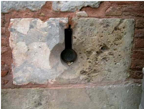
Figure 3. Comme cette meurtrière, réalisée en deux blocs sous Louis XI au Castillet (fin XV e siècle), certaines pierres des remparts de Philippe II du palais des rois de Majorque ont été taillées dans les carrières des hauts de Baixas en empruntant au contact de deux formations géologiques différentes : à gauche, la brèche orientale de Baixas (Eocène), à droite, la cargneule beige de l'Hettangien (limite Lias-Jurassique).
