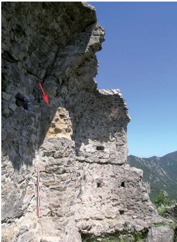
Figure 16 – Ruines de la chapelle castrale Sainte-Marie d'Ultrera construite avec les gneiss de l'environnement local dans la forteresse, au sommet d'un piton rocheux des Albères, et réaménagée au XII e s. avec un portail roman en marbre blanc. Seul l'arc triomphal (flèche) était parementé de tuïre (© C. Respaut).
