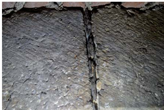
Figure 5 : Une ardoise fait usage de joint de réglage pour le calage des blocs d'un arc. Cette solution a été fréquemment utilisée dans tout l'édifice, elle prouve l'emploi de blocs livrés pré-taillés et ajustés par les maçons et non par des tailleurs de pierre présents sur le chantier. Un signe clair de construction à l'économie.
