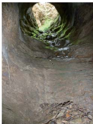
Secteur B : Vue de l'entrée de la mine depuis l'intérieur.
