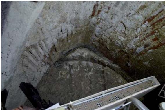
Figure 7 : Contact avec le mur d'un autre édifice ancien, en plein cintre. À gauche en entrant, sur le côté est de la première travée, la voûte s'appuie sur un mur latéral où se distingue un plein cintre. Relation chronologique à préciser.
