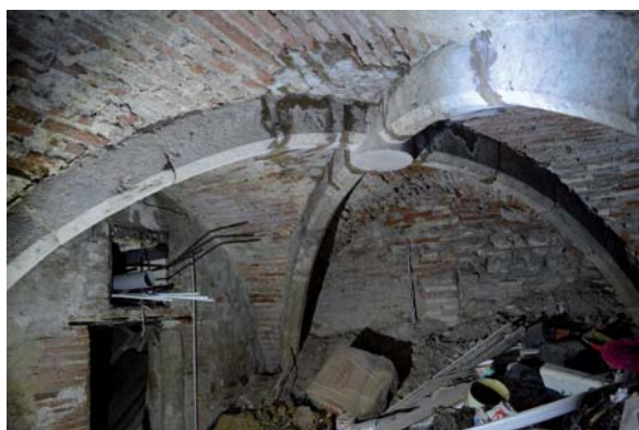
Figure 4 : À l'extrémité sud de l'édifice, la travée la plus profonde. La vue donne une idée de l'état intérieur de l'édifice. En face l'ouverture bouchée dans le mur est (E sur le plan ill. 2), à gauche le passage vers la travée trois : les travées ont été séparées au droit des arcs doubleaux pour en faire des caves individuelles. On remarquera le profil des arcs et la clef très sobres, ainsi que les alvéoles sur les blocs de marbre des arcs, cliché A. Catafau.
