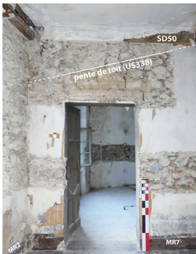
Figure 2 : Pente de toit vers la place lors de la phase 1. Élévation en pierres et mortier de terre (cliché C. Jandot, Inrap).
