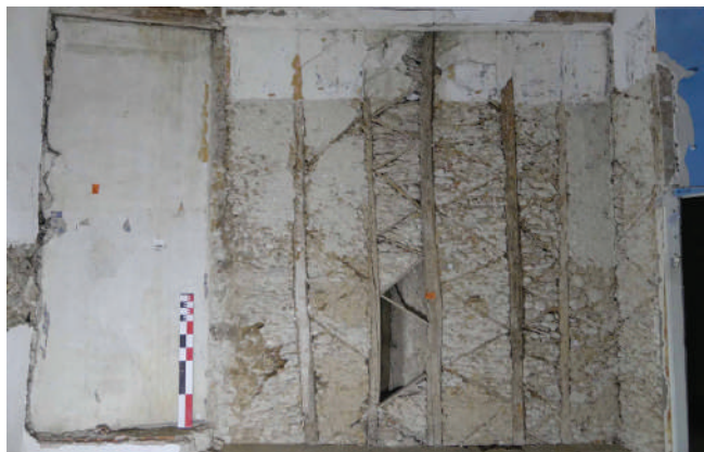
Figure 5 : Cloison à pan de bois du 1 er étage (cliché C. Jandot, Inrap).
