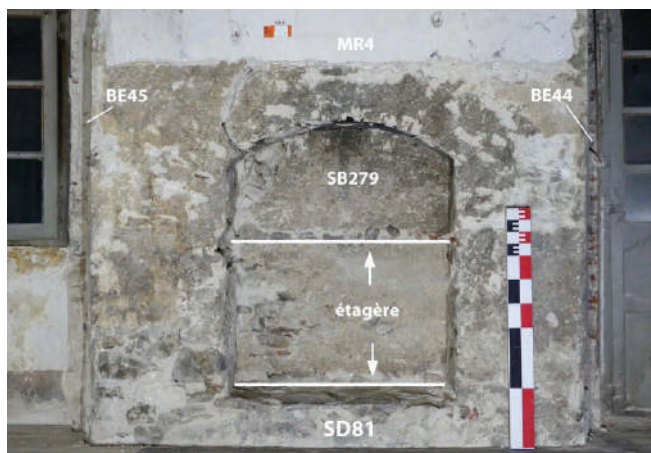
Figure 4 : Placard de la phase 2, aménagé dans le mur donnant sur la place. (cliché C. Jandot, Inrap).
