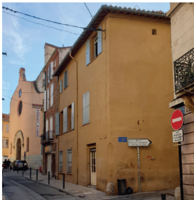
Figure 1 : Vue de la maison, Rue Grande la Monnaie (Saint-Mathieu, Perpignan).
