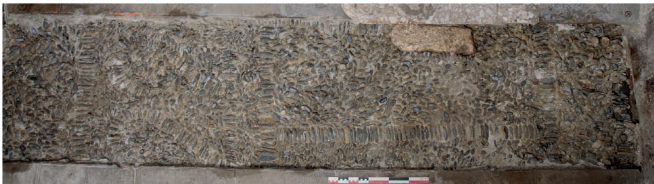
Figure 6 : Vue de la calade dans le vestibule d'entrée (cliché E. Ghanem, Inrap).
