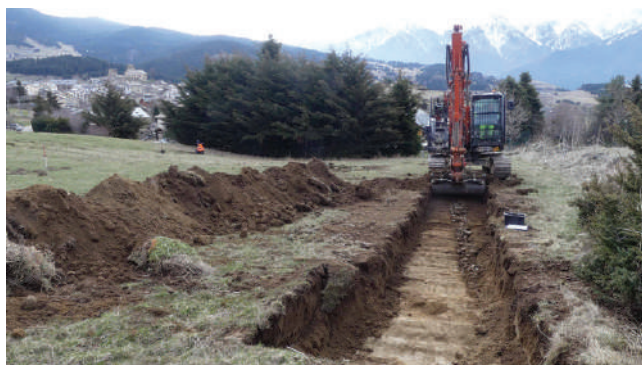
Figure 2 : Déroulement du diagnostic. Découverte d'un drain (non daté) en fond de tranchée et prospection des trous de taupe en cours préalable au terrassement mécanique (cliché C. Dominguez, Inrap).
