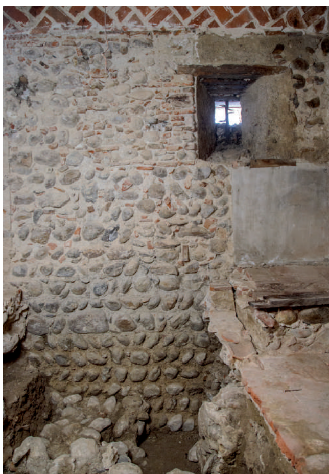
Figure 4 : Vue de l'enceinte, d'une archère et des reprises modernes (cliché C. Cœuret, Inrap)
