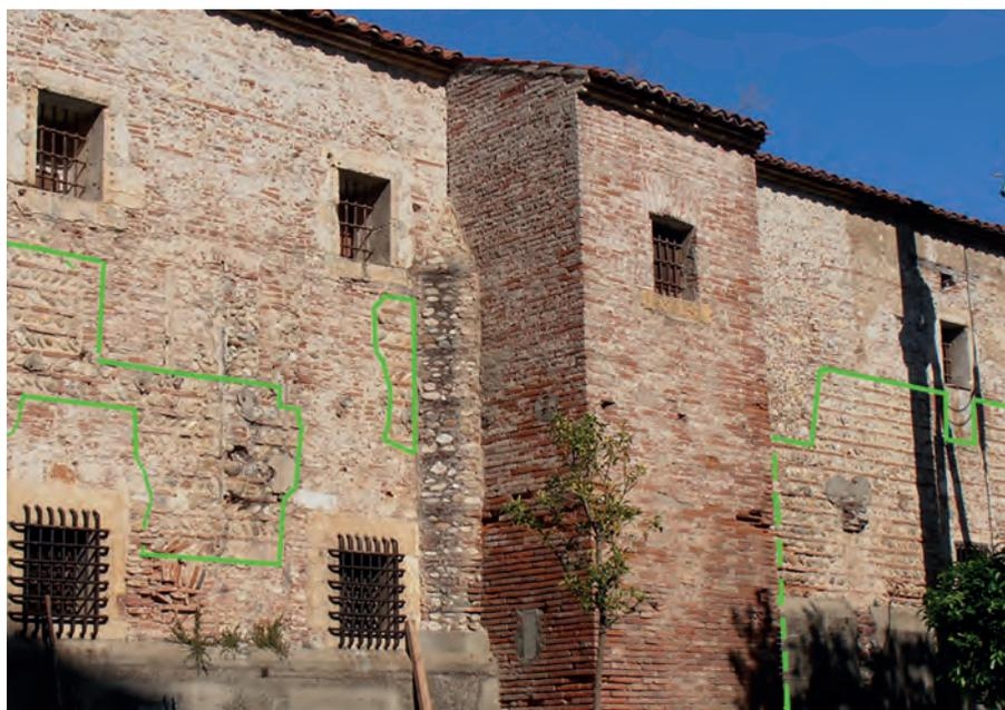
*Fig. 8 – Perpignan. Murs orientaux de l'ancien couvent des Clarisses après décroûtage et avec la trace d'une maçonnerie d'origine (1548-1550), entourée de vert ; au centre, la tour quadrangulaire construite en briques pour abriter les latrines de la prison au XIX<sup>e</sup> siècle. (© M. Martzluff).*
