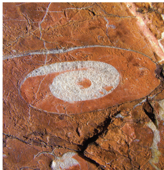
Fig. 2 a et b. Prades (Pyrénées-Orientales), fontaine de la place de la République en marbre griotte, 1867. En a : vue macroscopique des fossiles sur les parties polies, aujourd'hui dégradées par l'altération. En b : détail d'un moule de coquille déformé donnant l'aspect « œil de perdrix ». Longueur maximale, entre deux et trois cm. © Cécile Respaut.
