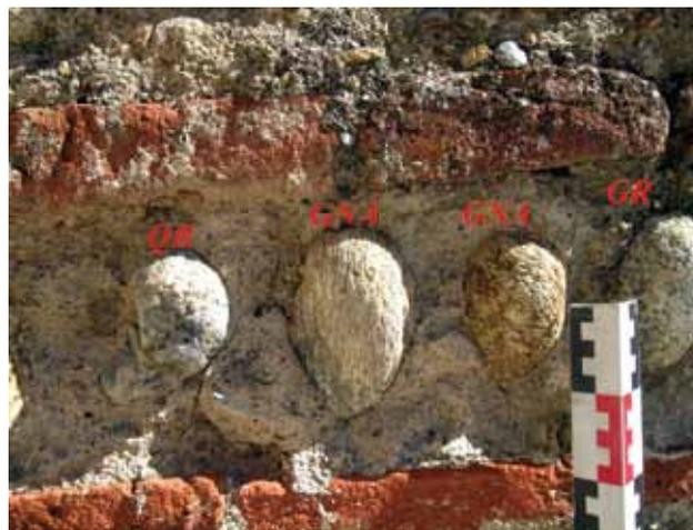
4 - Parapet du pont d'accès au château royal. Pris dans le mortier caractéristique de la construction médiévale, un rang de petits galets typiques des phases anciennes du chantier dont les quartz blancs (QB) et les granites (GR) présentent une surface de roulement fraîche (M7, tableau 4). Les gneiss (GNA) ont par contre subi une première phase d'altération qui commence à ouvrir les fissures ou qui colore l'un d'eux.
