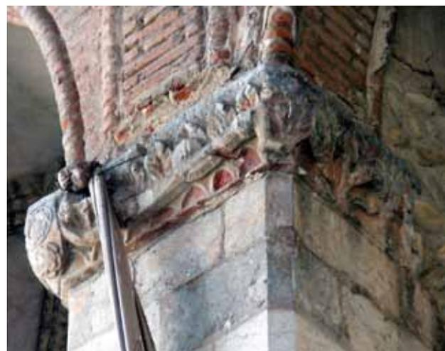
24 - Église des Carmes. Contrefort interne servant de mur à l'une des chapelles méridionales. La couleur des quartz brûlés tranche avec les parties restaurées avec des galets de l'alluvion actuelle (en B) et avec les parements neufs en brèche de Baixas (A). L'encadrement des portes est en briques (C) et le mur méridional comporte des chaînages en terre cuite (cl. C. Respaut).
