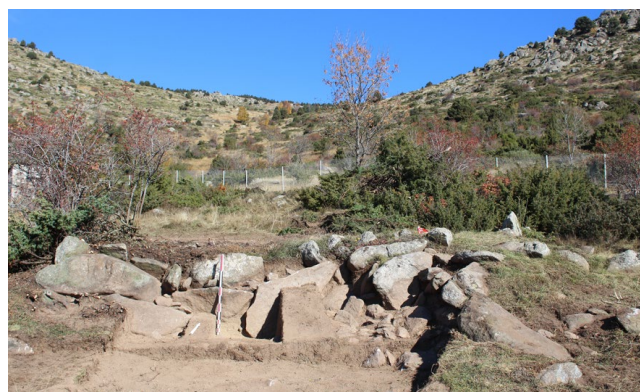
Figure 2 : Vue des terrasses
