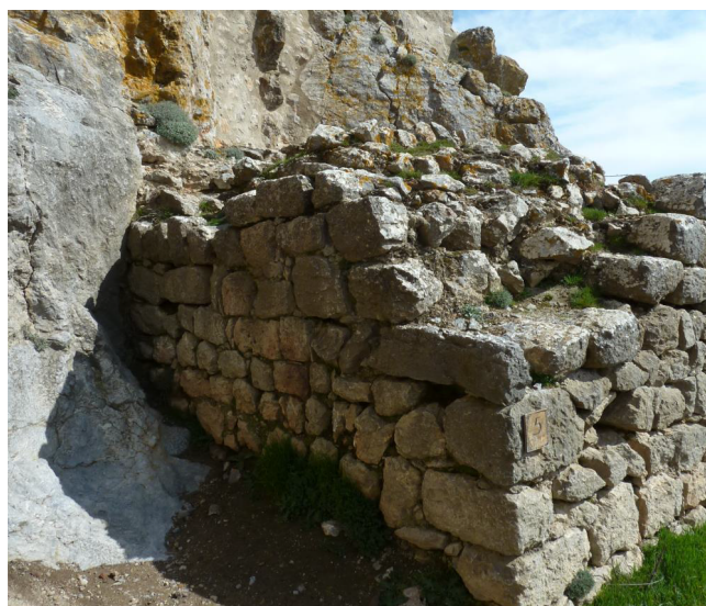
Figure 9 : Détail du mur de la citerne basse
