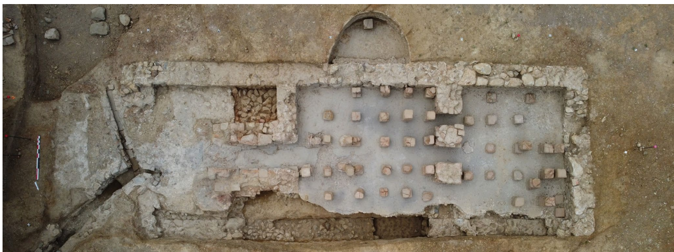
Figure 11 : Vue aérienne des thermes (cliché : C. da Costa, Inrap).
