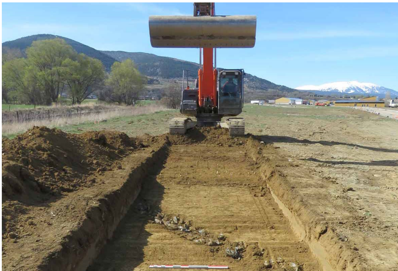
Figure 5 : Unique drain retrouvé lors de l'opération (cliché C. Durand, Inrap).
