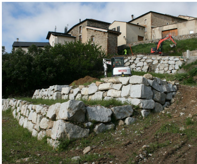
Figure 1 : Vue de la parcelle depuis l'est, présentant la mise en terrasse contemporaine.
