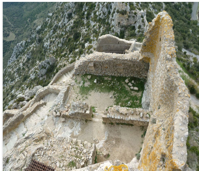
Figure 8 : Vue de la caserne et de la citerne
