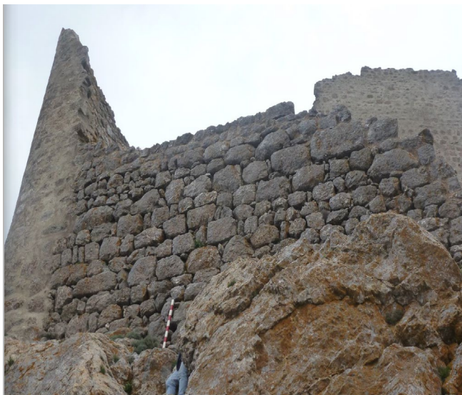
Figure 7 : Détail du mur en grand appareil de la caserne
