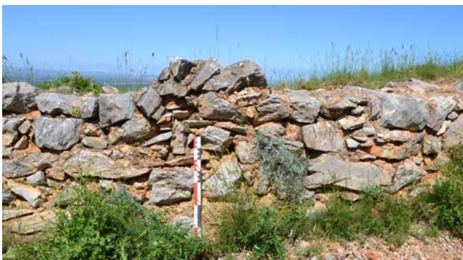
Figure 4 : Parement interne du mur est, vue depuis l'ouest (Cliché : E. Joffre, SAD).
