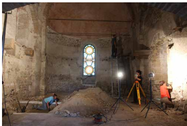
Figure 5 : Le diagnostic à l'intérieur de l'église Saint-Étienne (cliché : SAD 66).
