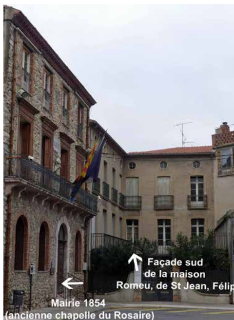
Figure 12 : Façade arrière de la maison (maison 7) accolée à l'annexe de la Mairie (ancienne chapelle du Rosaire). Cliché : C. Jandot (Inrap).
