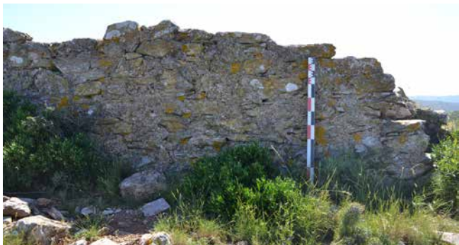
Figure 6 : Parement externe du mur est, vue depuis l'est (Cliché : E. Joffre, SAD).
