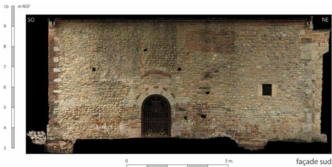
Figure 4 : Le mur gouttereau sud de la chapelle de Villerasse (clichés orthophoto de 2020 : Aurélien Bolo, Inrap).
