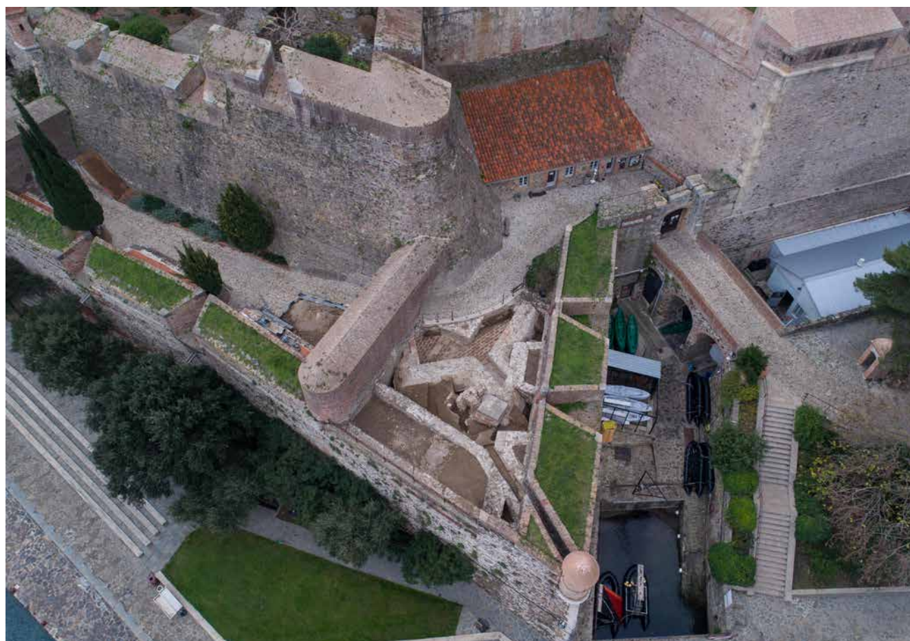
Figure 6 : Le bastion nord avec le bastion espagnol, ses redans et sa plateforme sommitale. Ce bastion construit au XVI e siècle dominait le port d'amont et culminait à 8 m de hauteur. Dans la seconde moitié du XVII e siècle, ce bastion est englobé par un bastion français équipé de banquettes de tir et d'une terrasse d'artillerie (© Philippe Benoist / Images Bleu Sud).
