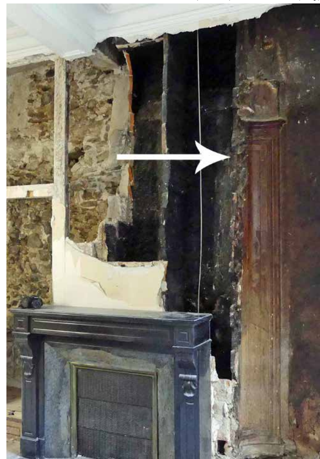
Figure 10 : Jambage de cheminée en stuc du XVIII e siècle démantelée par des restaurations du début du XX e siècle (maison 7). Cliché : C. Jandot (Inrap).
