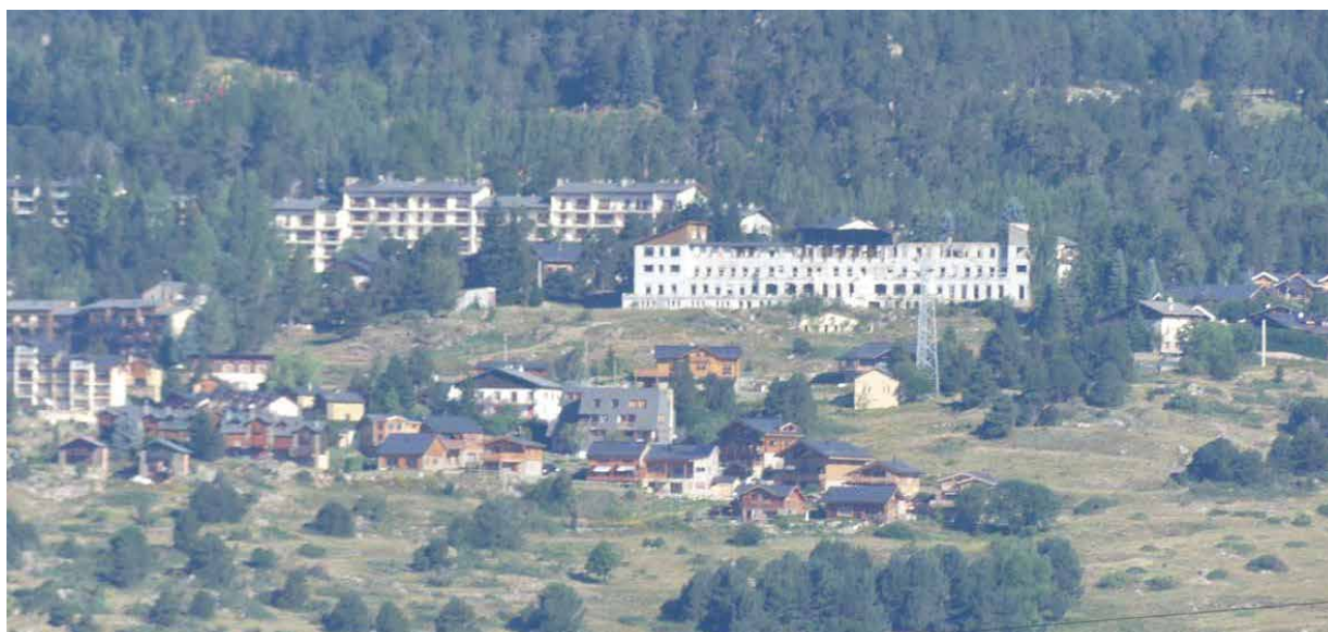
Figure 2 : Le grand bâtiment aujourd'hui détruit, en partie est de Font-Romeu. Les diagnostics archéologiques sont situés devant et derrière. (Cliché depuis Eyne, Christophe Durand, Inrap).
