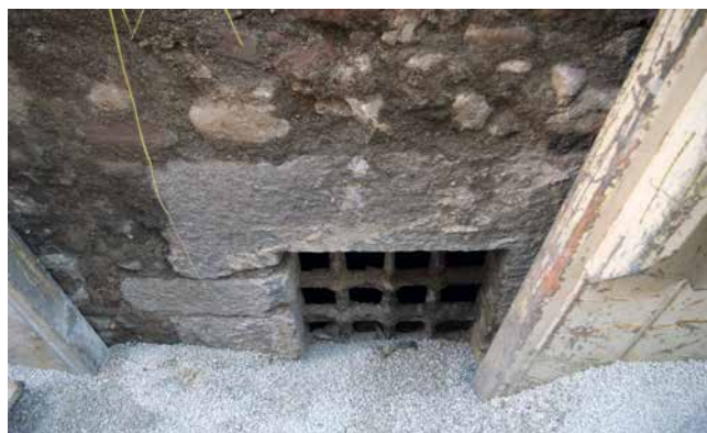
Figure 2 : Vue de la baie aménagée dans le rempart, depuis le nord-ouest (cliché : Barbe Adeline, Acter, 2019).
