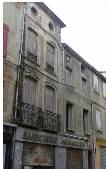
Figure 14 : Façade de la bijouterie Bès (maisons 2 et 3). Cliché : C. Jandot (Inrap).
