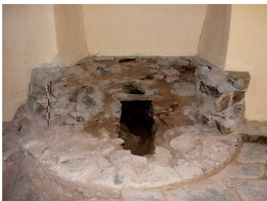
Figure 5 : La cuve maçonnée réutilisant un fond de fosse antérieur à l'édifice primitif (cliché : C. Mistretta Verfaillie).
