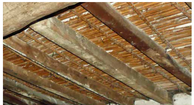
Figure 25 : Sous-pente de toit en roseaux transversaux ligaturés (maison 1). Cliché : C. Jandot (Inrap).
