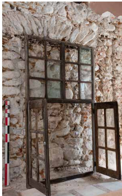
Figure 7 : Fenêtre croisée du XVIII e siècle mis en scène devant un encadrement bouché (maison 7). Cliché : C. Cœuret.
