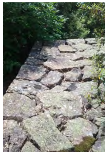
Figure 5 : Angle nord-ouest de la plateforme inférieure de la batterie (cliché G. Eppe, 2018).
