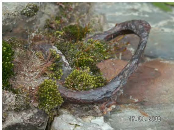
Figure 15 : Anneau fixé dans le rocher portant la pile B, côté rivière (cliché : É. Roudier).
