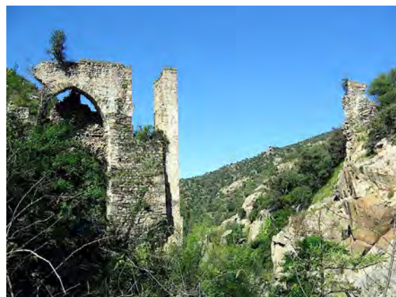
Figure 13 : Le pont-aqueduc de Labau dans les gorges de La Guillera à Rodès. Sur la gauche, arche en arc brisé ; au centre, l'élément vertical indique une réfection avec pile maçonnée et tablier de bois (hypothèse).
