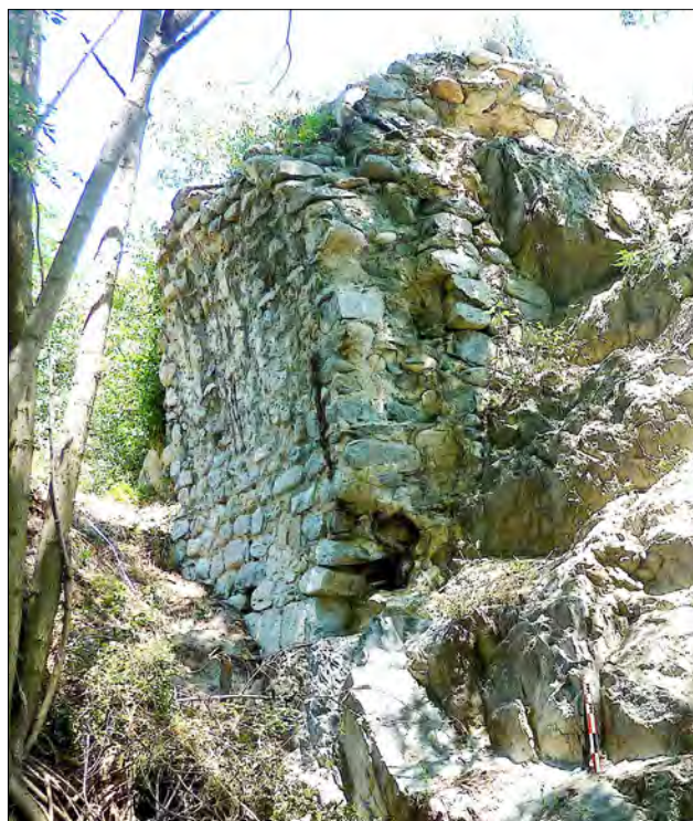
Figure 6 : La pile B, arche sud vue de l'aval.
