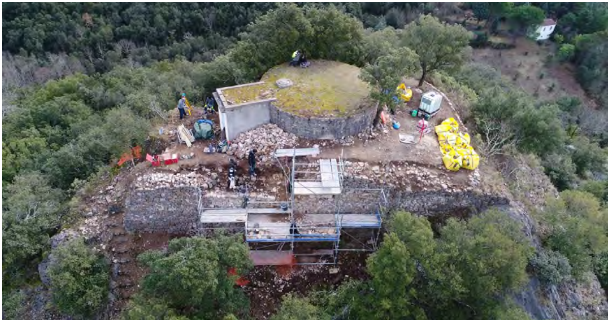
Figure 4 : Vue de la muraille ouest du Castell de Reynès (cliché S. Durant).
