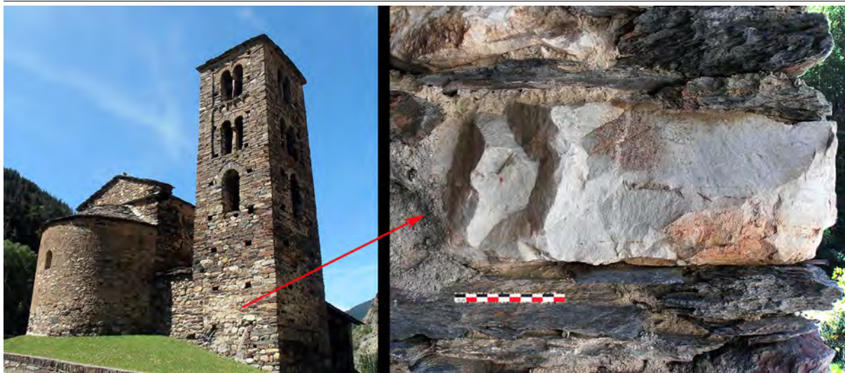
Figure 2 : Église Sant Joan de Caselles (Andorre). L'appareil de l'église romane primitive et de son clocher est formé de grésopélites schisteuses du substrat, en particulier pour le harpage des angles avec des blocs simplement brisés. Les parties ouvragées (colonnes et arcatures) furent réalisées avec un grès local et, surtout, avec du travertin de source des affleurements proches. Les galets très durs de porphyrite se trouvent aux environs de l'église dans les alluvions et dans les placages morainiques du versant. Les moellons de cette roche qui sont équarris au têtou correspondent aux parties ajoutées pendant les temps modernes (galerie ouest) ou à des réparations de même âge dans le bâti médiéval, par exemple à la base du clocher (© C. Respaut).
