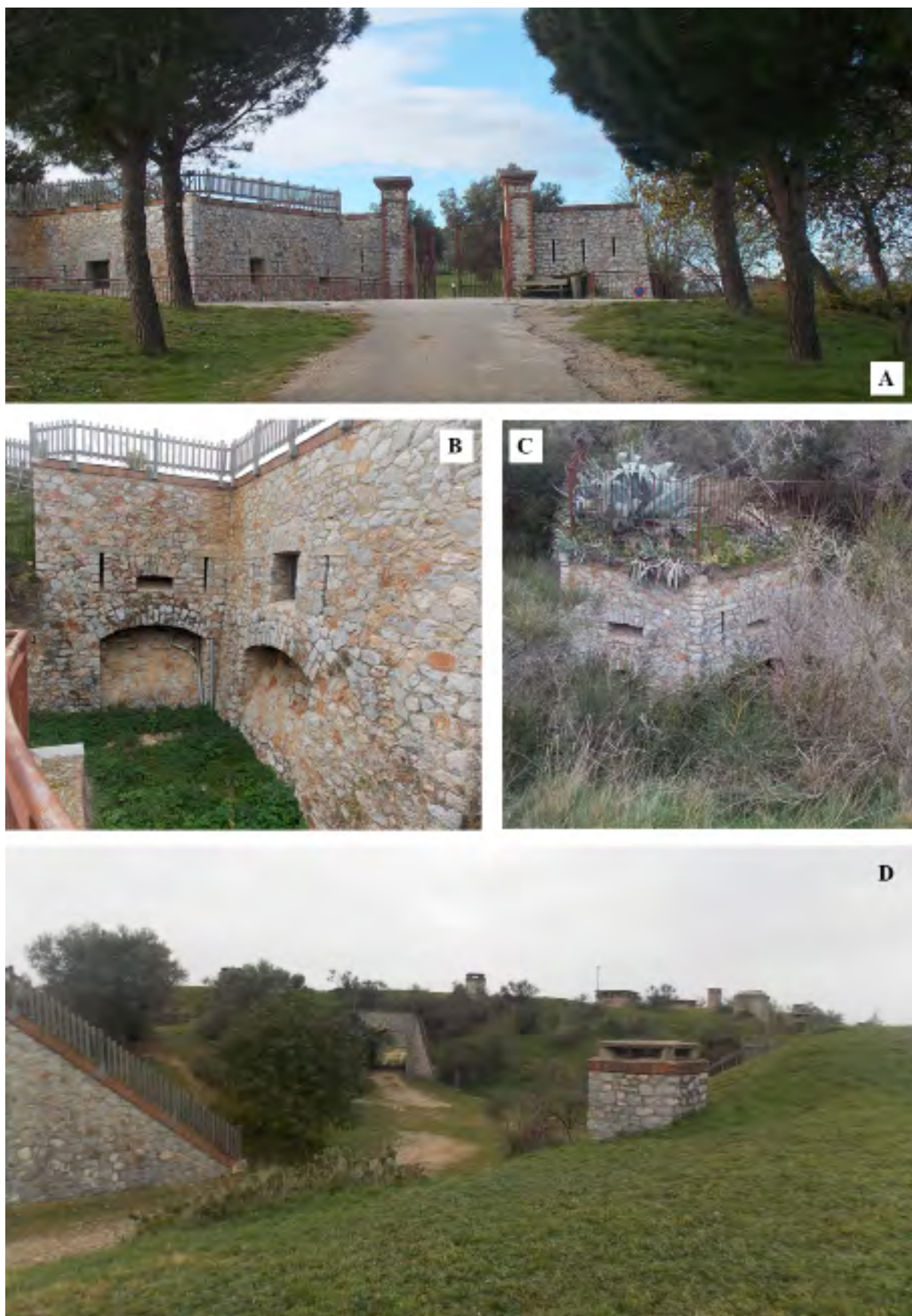
Figure 2 : N° 2A : vue de l'entrée du fort depuis l'ancien chemin militaire ; N° 2B : les défenses du corps de garde de l'entrée ; N° 2C : la casemate n°2 à trois faces et la grille d'escarpe ; N° 2D : le passage de la traverse n°6 et les aérations du casernement (clichés : G. Eppe, 2019).
