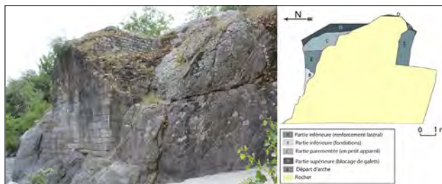
Figure 5 : La pile B, arche nord.
