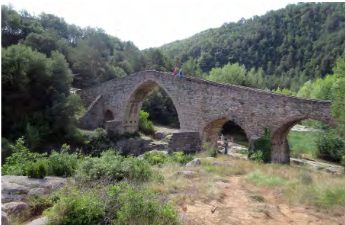
Figure 1 : Vue d'ensemble du pont de Pedret (© C. Respaut)
