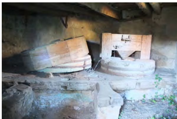
Figure 8 : Sur leur estrade, deux paires de meules complètes cerclées de fer ; une archure ou coffrage bois ; une trémie pour distribuer le grain.
