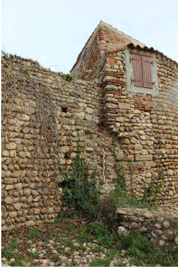
Figure 3 : Vue de l'angle sud-est des remparts actuels de Taxo d'Avall désignant le rempart initial (N/S), sa réduction (E/O) et la tour d'angle postérieure (vue prise du sud, cliché C. Jandot, Inrap).
