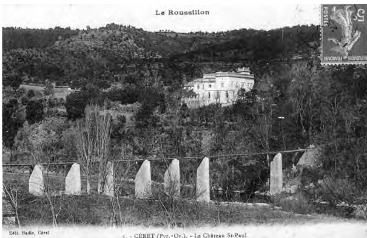
Figure 2 : Vue ancienne du château Saint-Paul et de sa passerelle privée qui enjambe le Tech.
