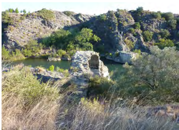
Figure 17 : Le pont d'Espira-de-l'Agly dans son environnement rocheux.
