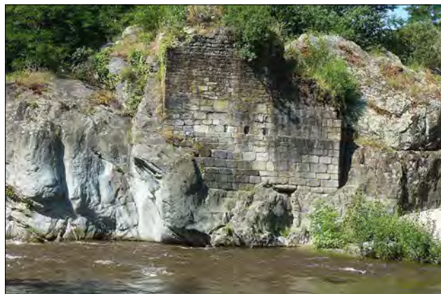
Figure 7 : La pile B, arche nord. On distingue les fondations en moyen appareil, le départ d'arche en petit appareil et, au-dessus, une possible reconstruction moins soignée.
