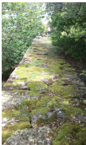
Figure 6 : Parapet de la plateforme inférieure (nord) de la batterie (cliché G. Eppe, 2018).
