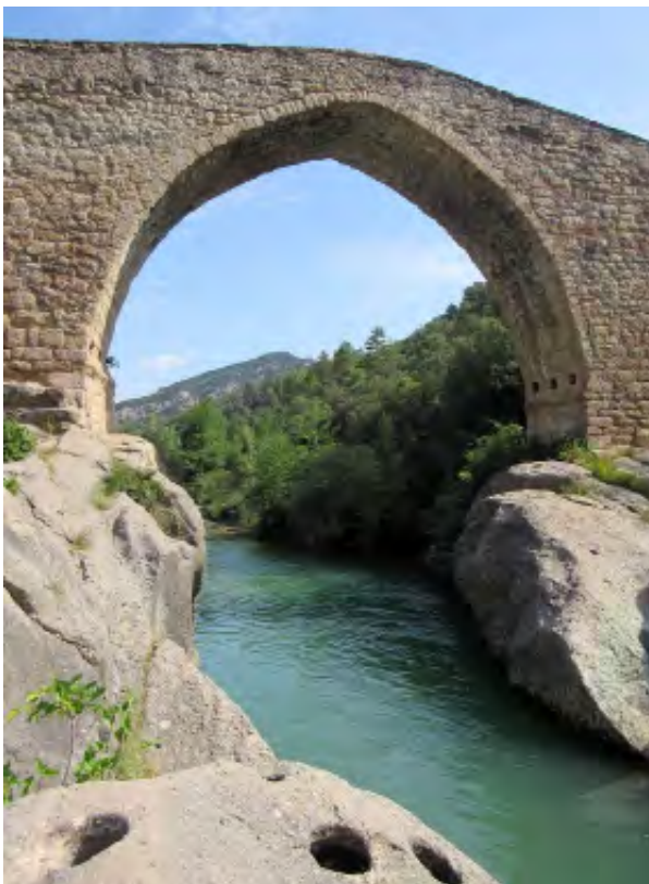
Figure 1 : L'arche principale du pont de Pedret de style gothique. Au premier plan les logements pour pieux de bois (© C. Respaut)
