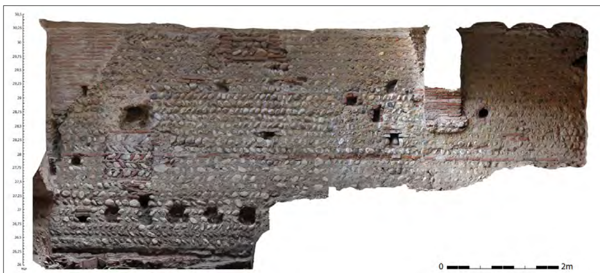
Figure 2 : Photographie redressée du parement oriental du mur médiéval 1441 (DAO N. Guinaudeau et G. Roguet, Acter).
