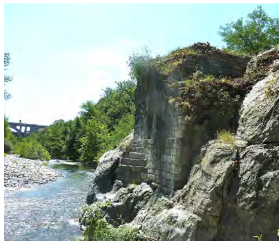
Figure 1 : Au premier plan, la pile (B) du Pont Vell sur la rive droite du Tech. À quelque 300 m en aval, le pont ferroviaire.
