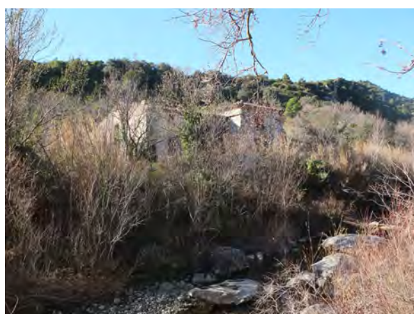
Figure 5 : Vue d'ensemble du moulin.
