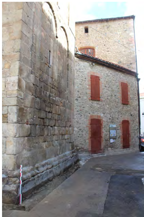
Figure 1 : Vue générale de la tranchée au pied du clocher roman, depuis l'ouest (cliché A. Barbe, Acter 2018).
