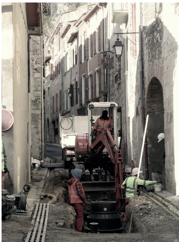
Figure 3. Travaux d'urbanisme rue Saint-Jean, à Villefranche-de-Conflent, en janvier 2018 (© C. Respaut).
