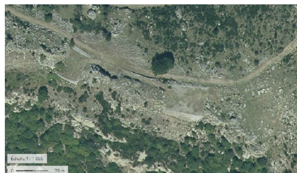
Figure 12. Les batteries du Col de la Branca à Montesquieu-des-Albères, source Géoportail, 2017.
