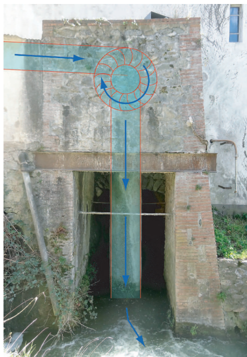
Figure 14. Position de la turbine et sa conduite forcée débouchant dans le canal de fuite (en arrière-plan la voûte de l'ancienne salle du rouet).
