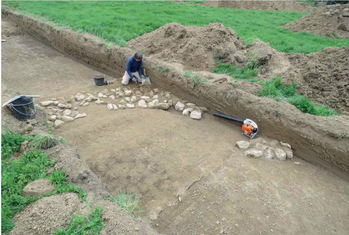
Figure 4. Saint-Génis-des-Fontaines, Le Village AE 64, murs de l'habitat médiéval en cours de nettoyage, cliché C Jandot, Inrap.
