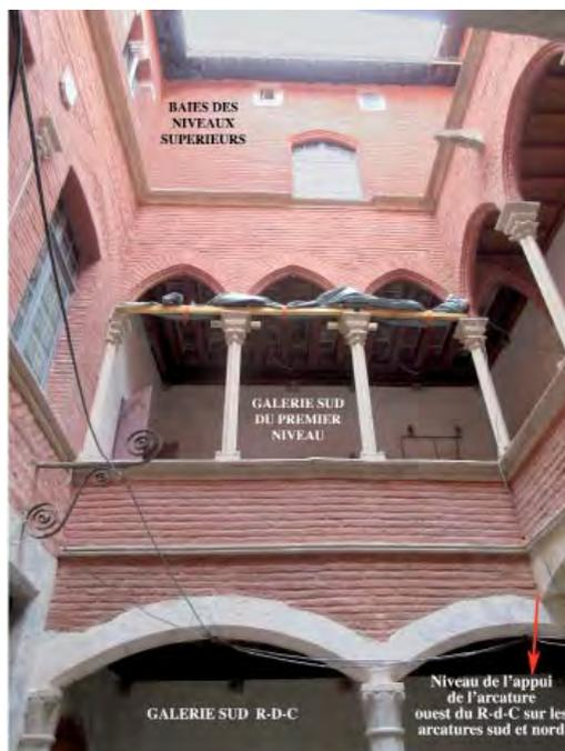
Fig. 4. Vue des élévations à l'intérieur du patio sur le mur sud : la galerie du rez-de-chaussée, celle du premier niveau, la fenêtre du second niveau et les deux baies quadrangulaires du dernier niveau. À droite, une gargouille moulée en ciment. La baie du haut correspond à la largeur de l'encoche dans le cordon qui prolonge le couvrement en grès à ciment siliceux du mur bahut.
