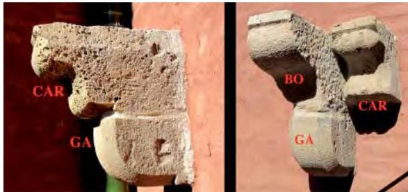
Fig. 11. Grès acide GR et cargneule blonde CAR associés sur les corbeaux du mur nord au second niveau. À gauche, corbeau ouest d'origine et à droite celui qui fut réparé avec un élément sommairement copié en brèche sombre de Baixas (BO), l'élément cassé étant fiché en appui à côté.
