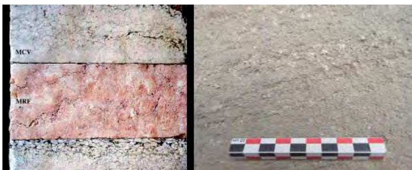
Fig. 9. Détails des faciès MRF et MCV du Conflent dans le portail et du grès à ciment siliceux sur les appuis des murs bahuts.
