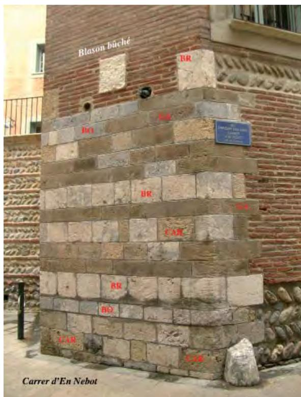
Fig. 16. Pan coupé du mur nord. Alternance de rangs de parements de brèches BO et BR de Baixas mêlés à quelques cargneules (CAR) avec le grès acide (GA). En haut, probable blason bûché.
