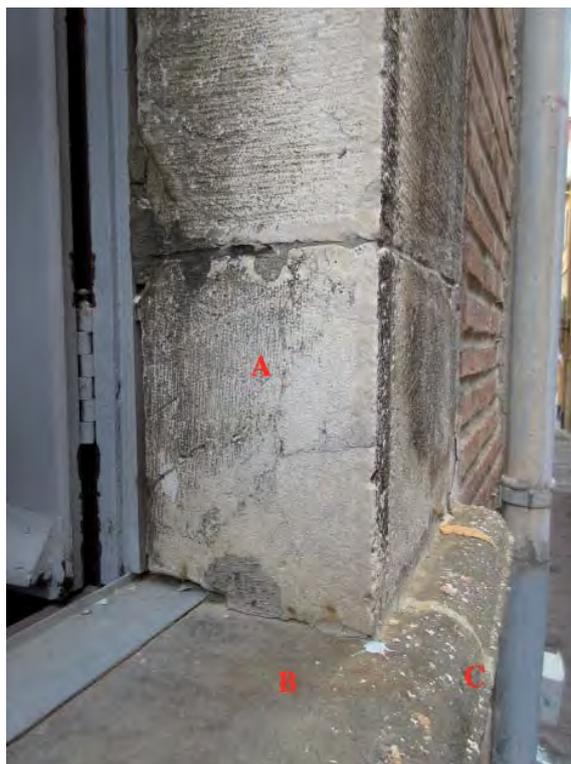
Fig. 10. Baie au-dessus du portail d'entrée : appui en grès siliceux en B avec moulure à listel typique en C et montants en BO de Baixas en A, avec traces de gradine.
