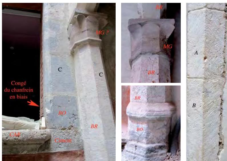
Fig. 7. Rez-de-chaussée du patio. À gauche, colonne octogonale de la galerie sud, angle est, près de la baie. Les roches sont les brèches BR et BO de Baixas, les cargneules sur l'appui de la fenêtre et le marbre MG de Gérone pour le chapiteau. En C : trace d'un layage horizontal. Au centre, la colonne de la galerie nord, angle ouest, avec un rare faciès BR à ciment rosé et la base typique. À droite, même galerie, angle est : traces de brettures (A) et de laye (B) en biais.
