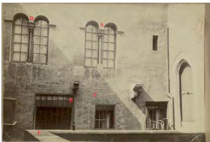
Fig. 3. Vue des élévations sur le mur nord du patio à partir de la terrasse du second niveau avec les corbeaux (celui qui est à droite a été réparé). A et D : baies 3 et 4 ; B : ouverture du XIXe s. qui a supprimé la base du corbeau central ; C : briques mécaniques ; E ; angle en pedra de les Fonts du couvrement du mur bahut, fait en grès acide. Cliché pris par Brutails entre 1884 et 1889 ; Archives U. Bordeaux.
