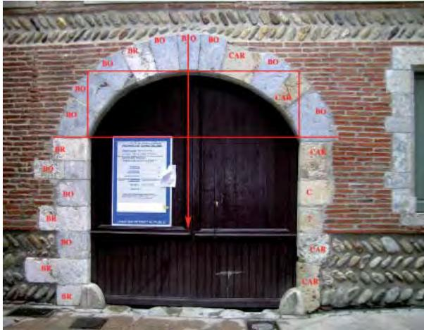
Fig. 17. Porte charretière donnant sur le carrer d'en Nebot. Brèches de Baixas (BO et BR) à gauche et cargneules blonde de Calce ou de Baixas à droite (CA) avec un calcaire (C) et une roche indéterminée. Le quadrillage marque le décalage au niveau du départ de l'arc sur le contre-sommier.
