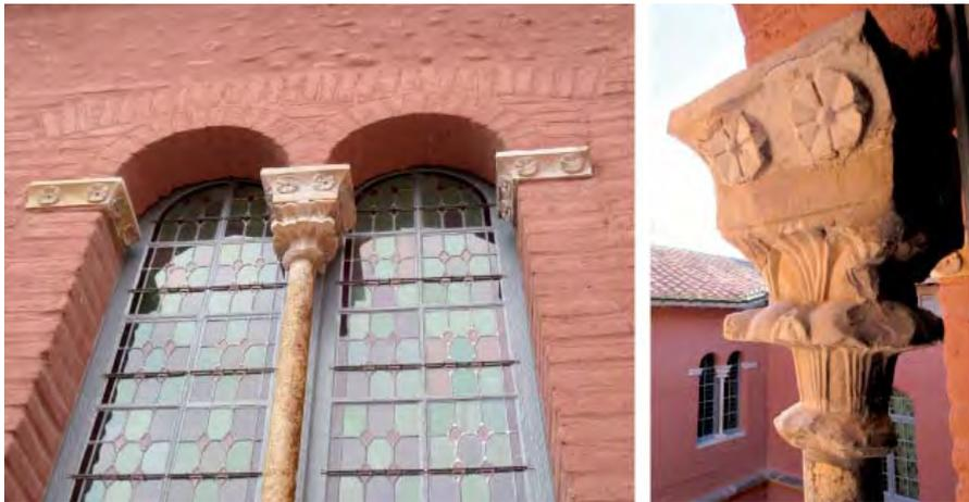
Fig. 19. Vues de la baie 5 sur le mur ouest du dernier niveau. Colonne segmentée en calcaire gréseux (?) et chapiteau d'origine en calcaire compact (détail à droite).
