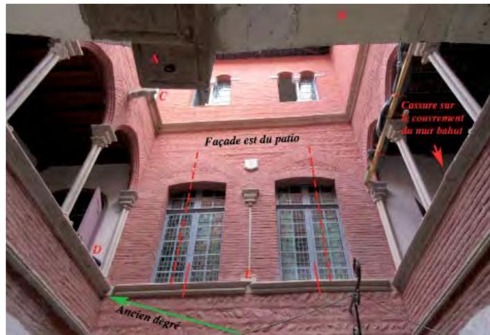
Fig. 13. Galerie du premier niveau. En A : pilier en tas de charge soutenant les arcatures ouest du rez-de-chaussée, en B ; en C : corbeuse reconstituée dans le mur bahut du second niveau, celui d'origine ayant sans doute provoqué l'érosion du pilier central de la galerie sud au rez-de-chaussée (en bas à droite) ; en D, la partie fragmentée et retaillée sur l'appui en grès du mur bahut du premier niveau, là où arrivait l'escalier extérieur médiéval (flèche verte).
