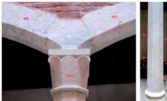
Fig. 12. Colonne centrale nord de la galerie du rez-de-chaussée en marbre nummulitique (faciès MBG) avec son chapiteau probablement restauré dans la même roche. À droite, la colonne centrale de la galerie sud avec une érosion marquée en hauteur par les éclaboussures des eaux tombant sur le sol pavé du patio (entre les flèches).
