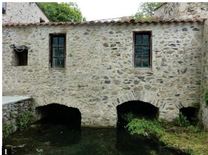
Fig. 1. Le moulin farinier de Sournia. Au bas, l'ouverture des deux chambres voûtées où sont installées les roues hydrauliques. À l'étage, la salle des meules ; le moulin comptait deux paires de meules placées dans l'axe des salles voûtées et des fenêtres.
