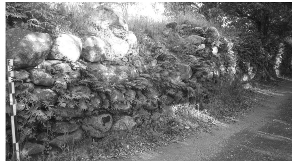
Figure 2 : Mur de terrasse de l'ancien chemin de Maureillas, bâti avec de gros galets issus de l'ancien bourrelet alluvial. Cliché J. Kotarba.
