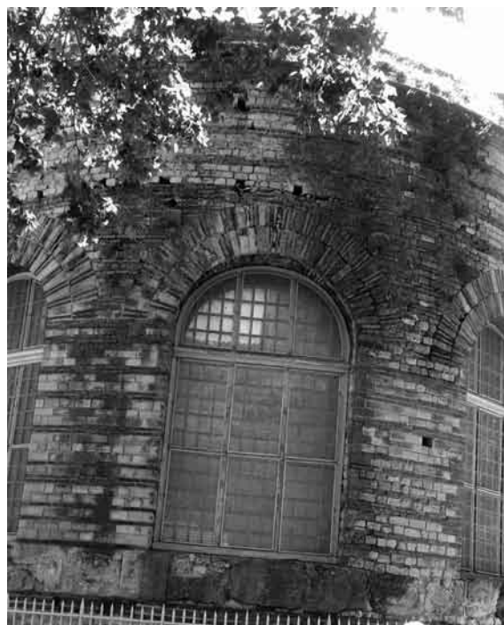
Les thermes, vus de l'extérieur (cliché G. Eppe)
