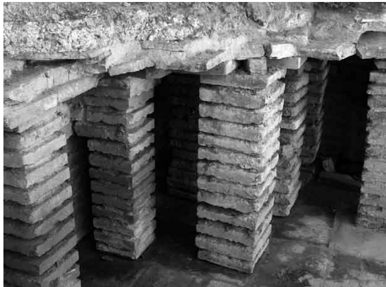
Système d'hypocaustes servant à chauffer le caldarium (cliché G. Eppe)
