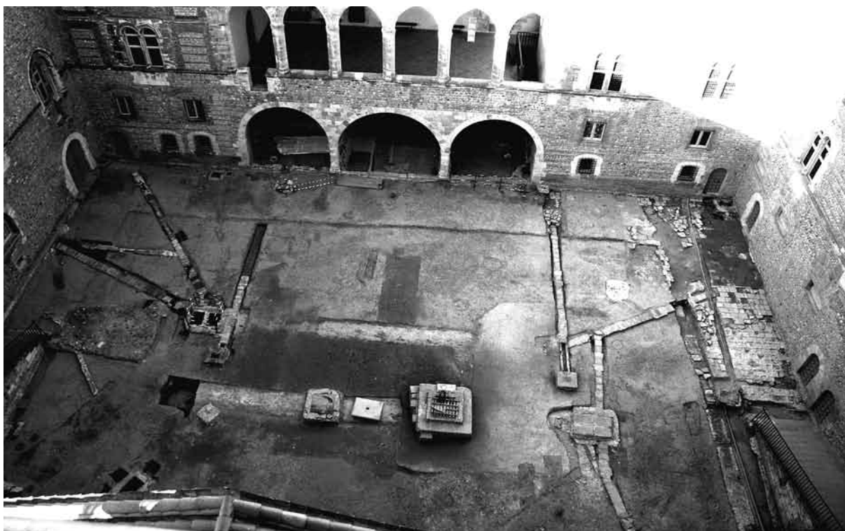
Figure 2 : Vue générale de la cour avec le système hydraulique (cliché PAD, CG66).
