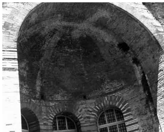
Voûte de la piscine du caldarium (cliché G. Eppe)
