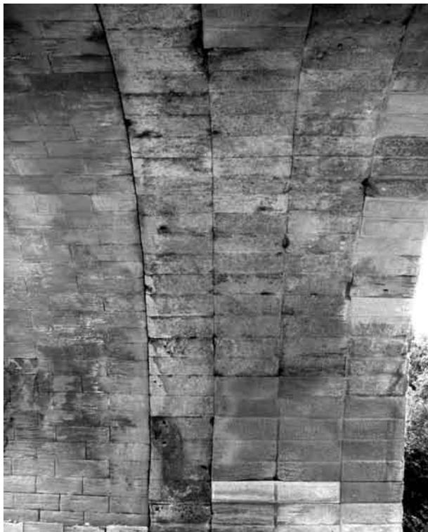
*Fig. 12 : Détail de l'intrados. Sur la droite les quatre rouleaux de l'aqueduc antique. À gauche le rouleau unique du pont réalisé par Henri Pitot au XVIIIe siècle. Les moellons plus clairs à la base de l'arche correspondent à une restauration récente.*
