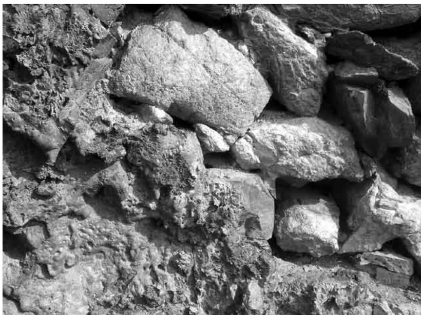
Fig. 9 : Four n° 2, vitrification du parement intérieur. Cliché M. Martzluff.
