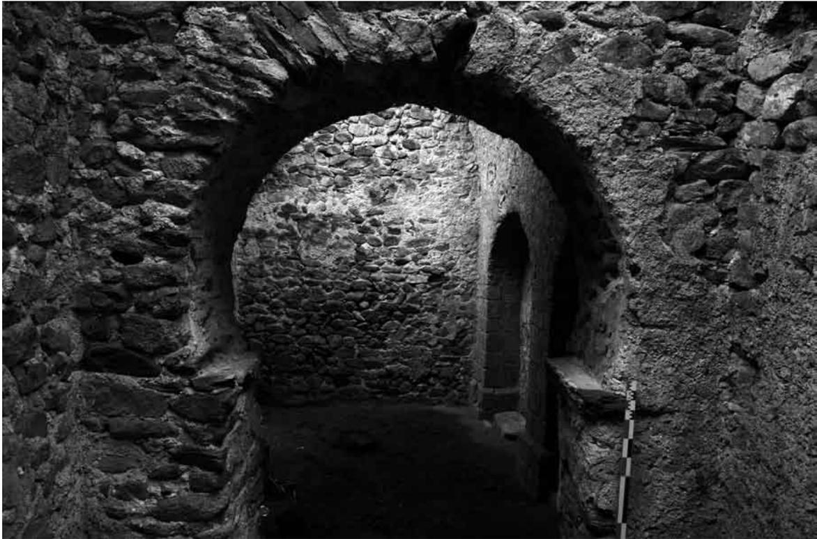
Fig. 1 : Arc triomphal du choeur, face est : mise en oeuvre de l'arcade (cliché ACTER).
