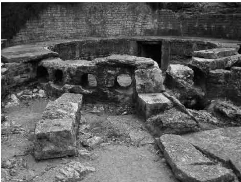
Fig. 6 : Le castellum divisorium à Nîmes. Au fond, l'arrivée de l'eau de l'aqueduc. Au premier plan, les orifices servant à la distribution.
