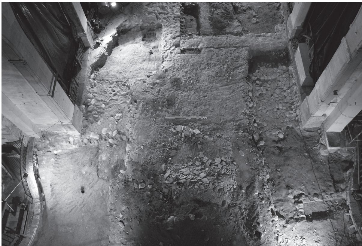
Eglise Saint-André de Saint-Féliu-d'Avall : vue générale du chantier (cliché ACTER).
