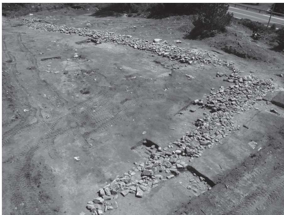
Fig. 1 : Deux des murs en pierre sèche structurant le versant vus de l'ouest (cliché J. Vial).
