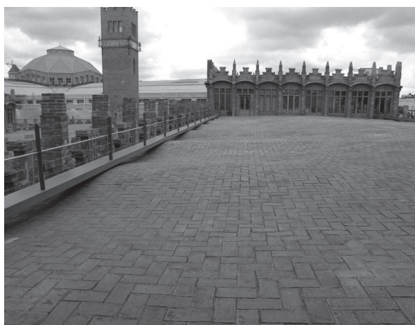
Toit de la Caixa de style Art Nouveau.
