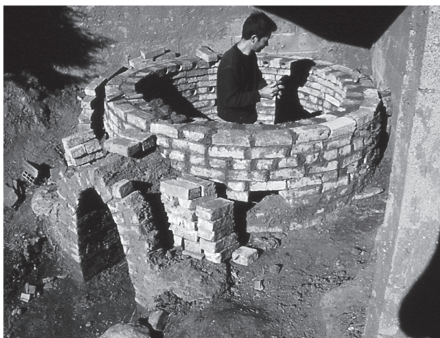
Fig. 12 : Le four à barres en cours de construction en 2002 (cl. J.-M. Giorgio).
