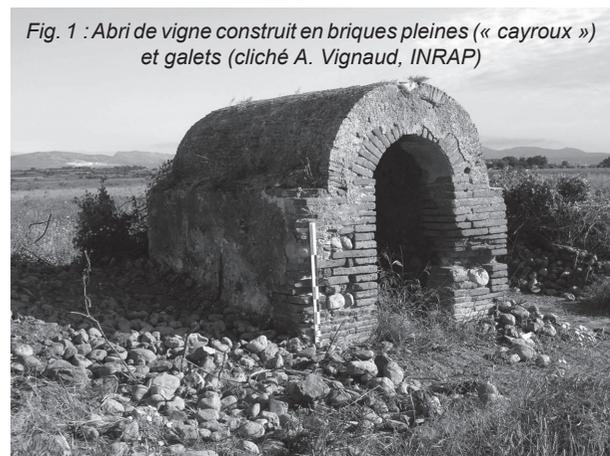
Fig. 1 : Abri de vigne construit en briques pleines (« cayroux ») et galets (cliché A. Vignaud, INRAP)
