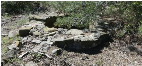
Figure 8 : Citerne située à 35 m au nord-est du M-2 (cliché A. Toledo i Mur, Inrap).
