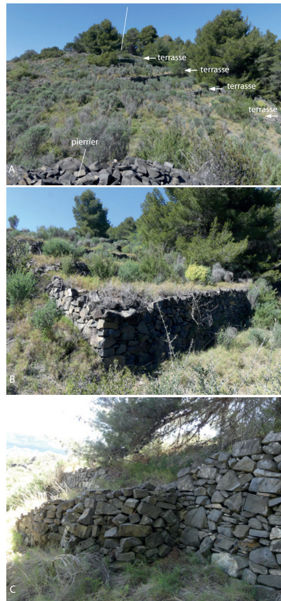
Figure 4 : A : vue générale du sous-ensemble de terrasses (ensemble A). B : détail de l'angle de la terrasse inférieure. C : rampe d'accès entre deux terrasses (clichés : A. Toledo i Mur ; DAO : Ch. Cœurret/Inrap).
