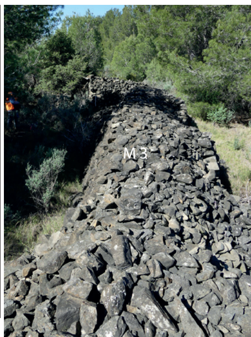
Figure 7 : Vue du mur M-3 (cliché A. Toledo i Mur, Inrap).
