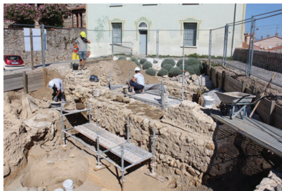
Figure 4 : Les travaux de restauration des maçonneries de la cathédrale primitive (cliché J. Bénézet, SAD66).
