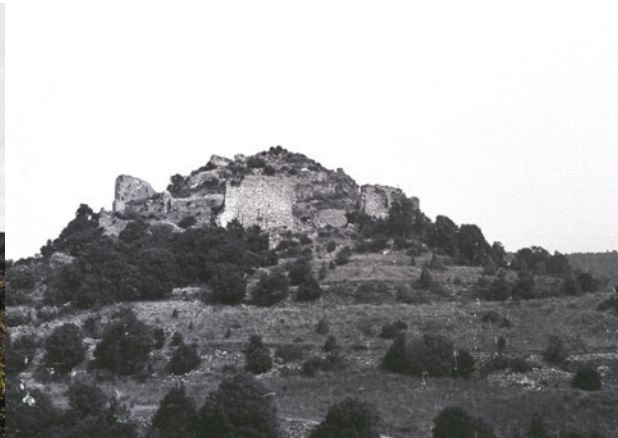
Figure 5 : Termes vue du front ouest seconde enceinte (Lucien Bayrou© état 1975).
