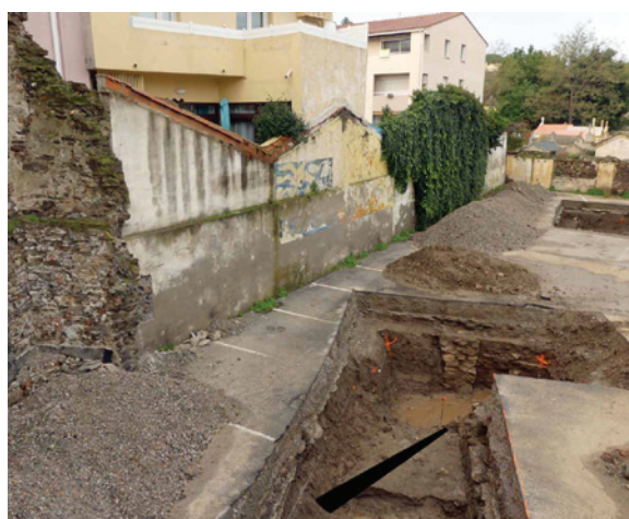
Figure 3 : Vue d'ensemble du mur de délimitation du cimetière (cliché C. Jandot, Inrap).
