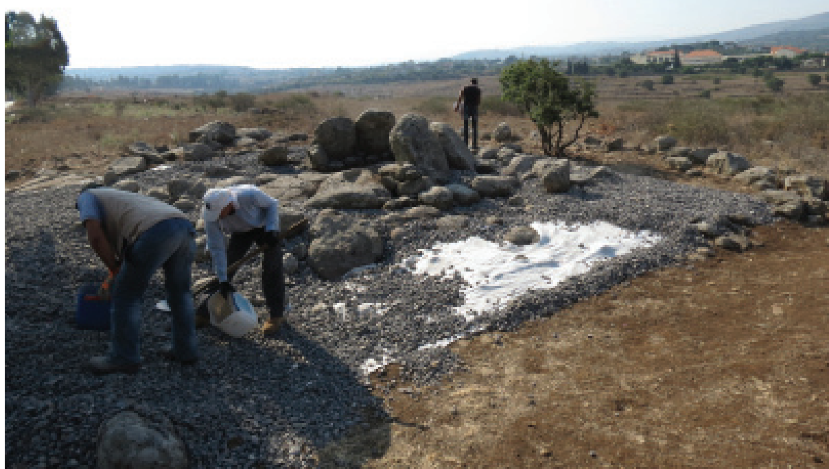
Figure 5 : Pose de géotextile autour du dolmen n°1 de Watta © Mission Menjez 2018
