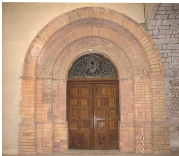
Figure 2 : Portail Notre-Dame-dels-Correchs (église de Saint-Jean-le-Vieux). Le sondage a été réalisé sous l'arcade, à droite sur le cliché. (cliché N. Guinaudeau, Acter)
