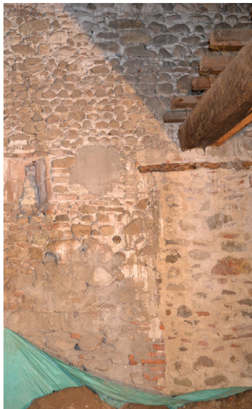
Figure 3 : L'un des murs de la grange d'époque moderne (XVIe-XVIIIe s.) dans laquelle a été réalisé le sondage (cliché J. Bénézet, SAD66).
