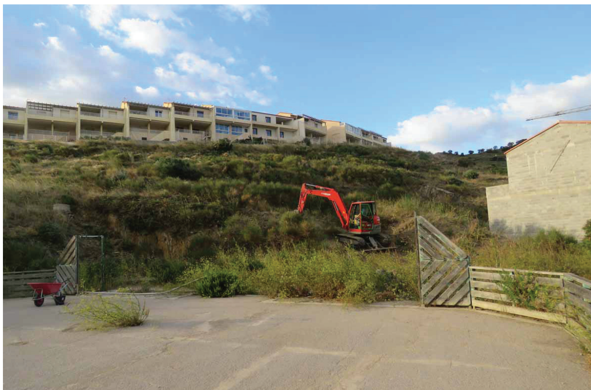
Figure 1 : Vue générale du versant à aménager, depuis le city stade (cliché J. Kotarba, Inrap).
